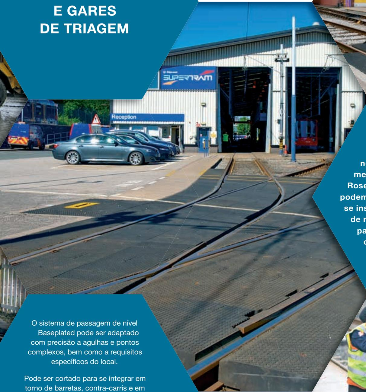
Feitos de borracha maciça, sem lacunas nem componentes metálicos, os painéis Rosehill Baseplated podem ser cortados para se inserirem em aparelhos de mudança de via, passagens de nível e outras infraestruturas da via.
