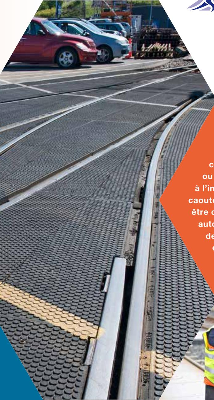
Remplies dans son intégralité de caoutchouc sans vide ou pièces métalliques à l'intérieur, les dalles en caoutchouc Rosehill peuvent être coupées pour s'adapter autour des interrupteurs, des passages à niveau et d'autres infrastructures de voie.
