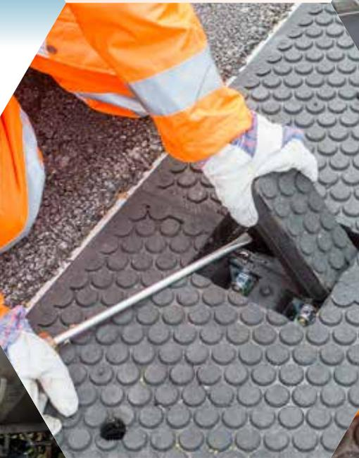
Les panneaux sont solidement fixés les uns aux autres par un système de tiges de Rosehill Rail, assurant le passage à niveau le plus sûr possible. Les boulons sont recouverts et donc protégés par des plaques en caoutchouc.
