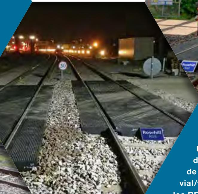
La forma ideal de utilizar vehículos de mantenimiento vial/ferroviario en la vía; los RRAP de Rosehill son perfectos para tener puntos de acceso temporales, semi-permanentes o permanentes.
