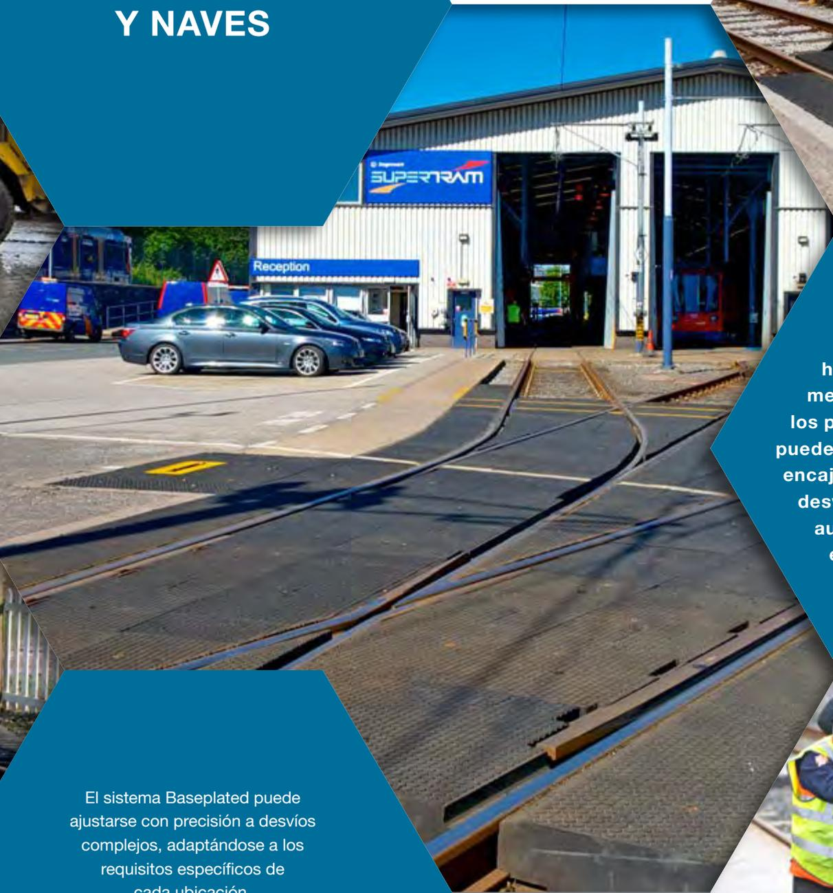
Fabricados con caucho macizo, sin huecos y sin piezas metálicas en el interior; los paneles Rosehill se pueden cortar para encajar alrededor de desvíos y otros elementos auxiliares existentes en las infraestructuras ferroviarias.
